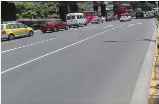
图 1 薄层加铺罩面工程
