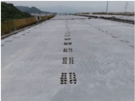
图 3 负弯矩区桥面板
