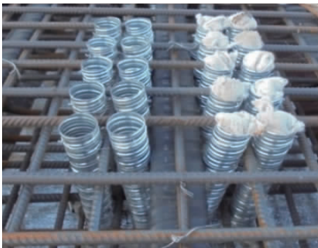
图 2 钢套筒群钉构造
