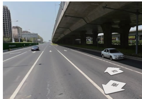
图2 桥梁顶升段现状之实景
