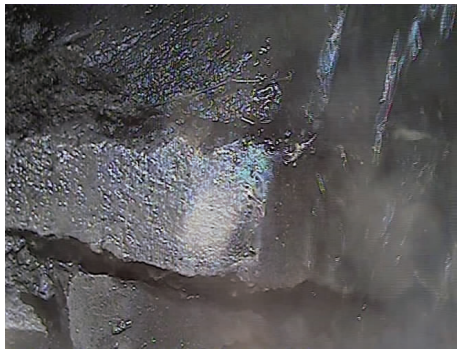
图2 管道破裂2级
