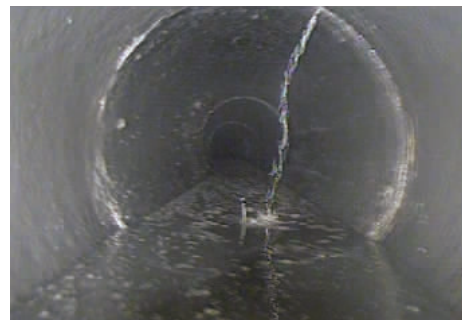
图 1 管道渗漏 3 级
