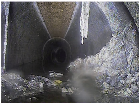
图3 管道脱节3级
