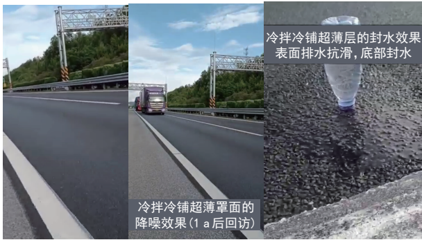
图 3 冷铺薄层试验段展示
