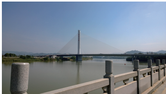
图1 梅州市广州大桥实景图
