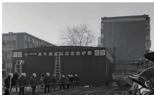
图 14 泥浆防护棚之实景
