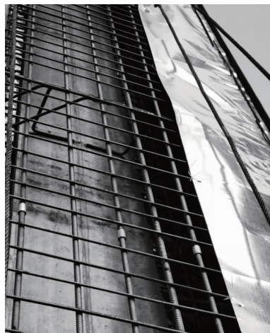
图 7 止浆铁皮临时固定之实景
