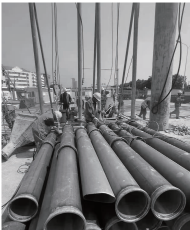
图1 导管安装噪声现场
