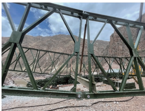
图2 单排导梁部位设置下弦接头
