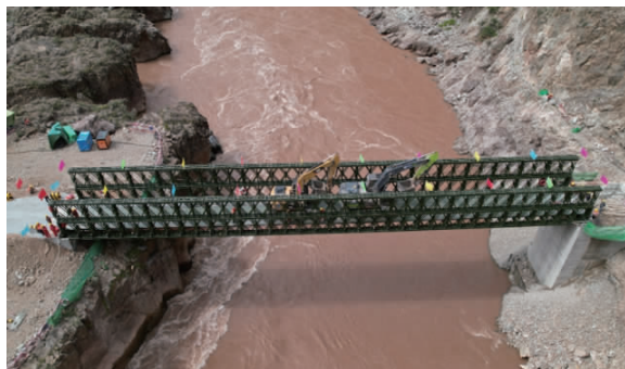
图 10 荷载试验(满载工况)
