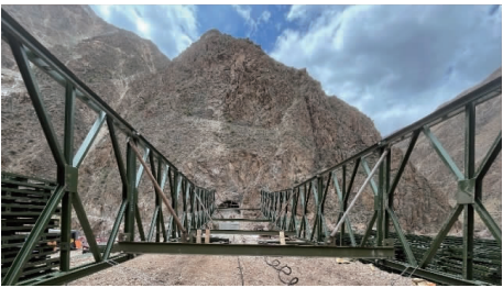
图 7 简易横梁、抗风拉杆安装
