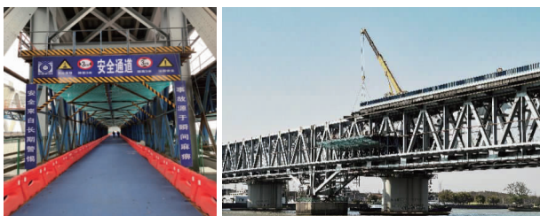
(a)下层通行防护及警示 (b)上层拆除期间下层防护
