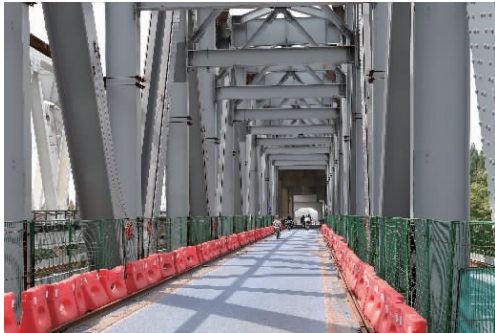
图6 松浦大桥上层施工下层通行
