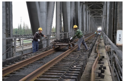
图5 松浦大桥下层改建
