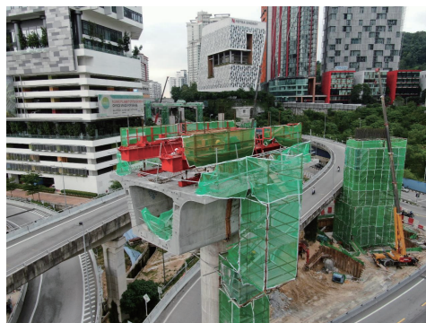
图 7 吊装辅助装置现场安装图
