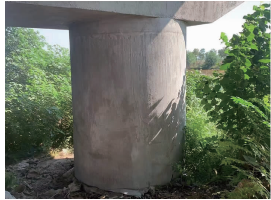
图 11 墩柱加固现状图
