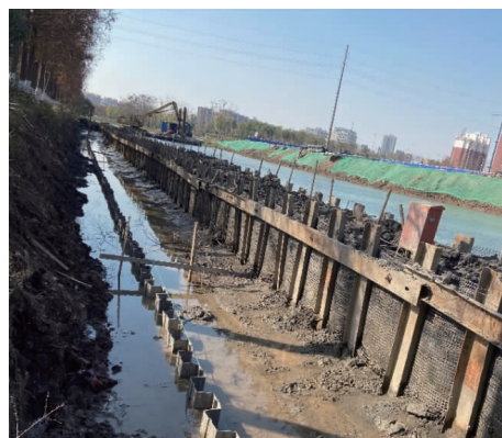
图6 该工程中塑钢板桩的应用
