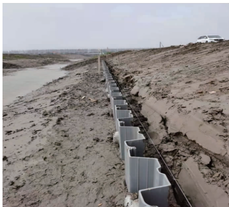
图2 该工程中塑钢板桩的应用
