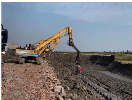
图 8 该工程中塑钢板桩的应用
