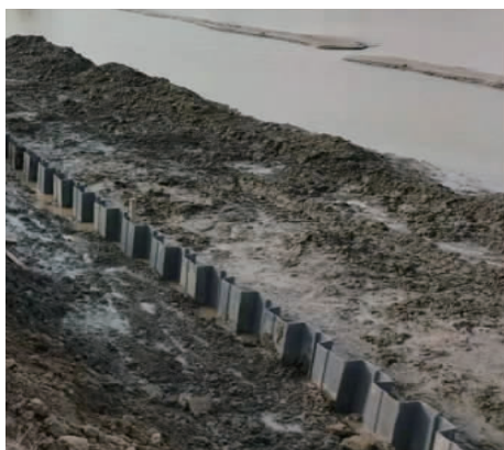
图4 该工程中塑钢板桩的应用
