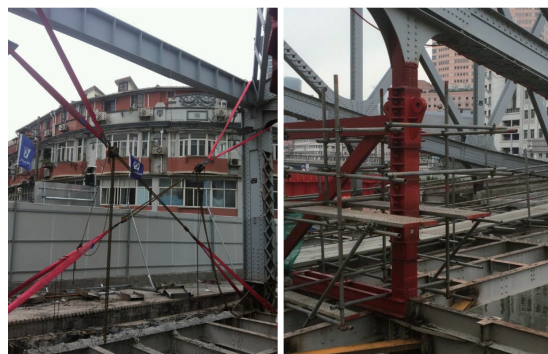
图 7 移桥加固措施
