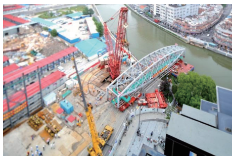
图 5 整体移运至临时厂房内进行大修
