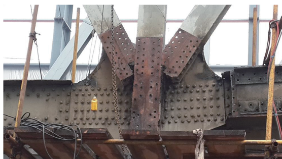
图 6 节点锈蚀程度超预期
