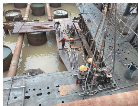
图7 钢板桩止水施工
