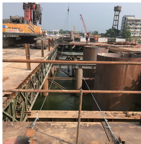
图 4 钻挖钻机引孔施工
