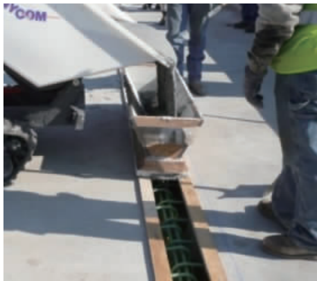
图7 新型横向接缝浇筑混凝土
