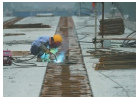
图 6 传统桥面湿接缝焊接连接
