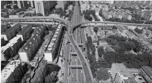
图 11 一期工程完工实景
