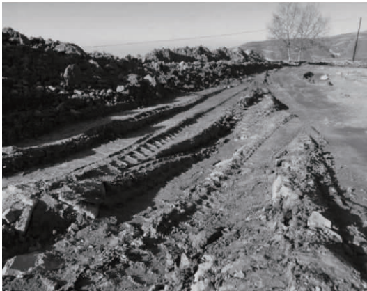
图1 项目工况现状
