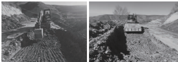
(a)不良路段开挖处理 (b)开挖后压实处理
