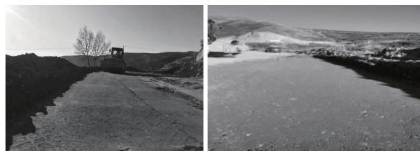
(a)格室布设后压实 (b)试验段压实后工况
