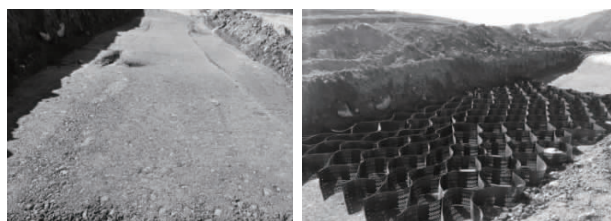
(a)开挖压实处理后 (b)开挖后土工格室的布设
