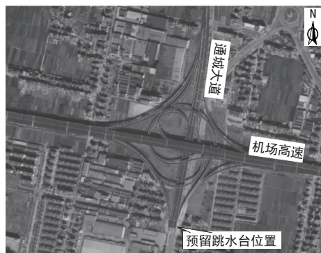
图2 机场高速-通城大道立交建成情况
