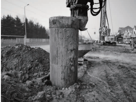
图3 护筒施工现场照片
