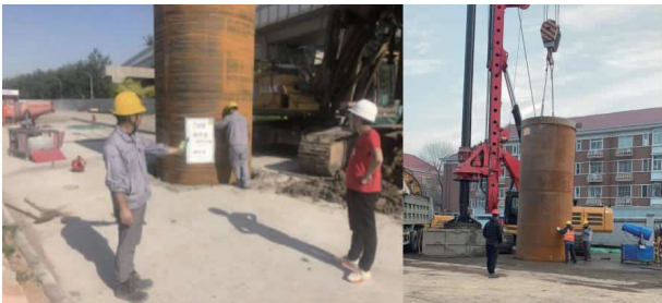
图 10 钢护筒安装实例
