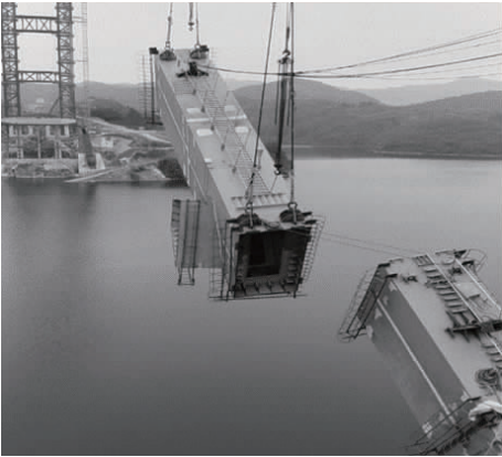
图 4 拱肋单幅吊装施工
