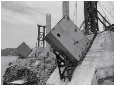
图 3 首节段定位支架
