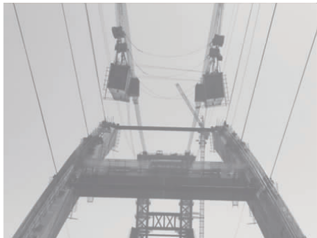
图6 双幅拱肋同步安装施工
