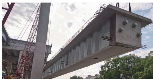
图13 波形钢腹板组合小箱梁现场吊装
