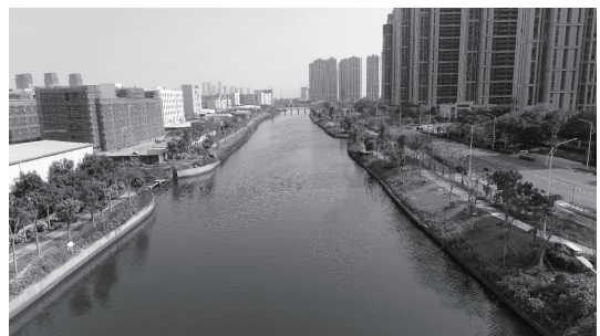
图9 排洪港河道综合治理后照片
