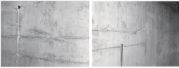
图2 腹板裂缝示意图
