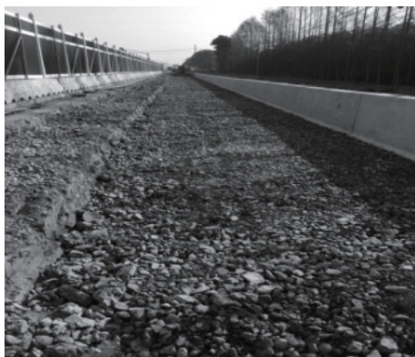
图 4 沥青铣刨料填筑路基
