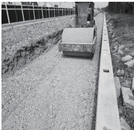
图 5 再生碎石混合料填筑路基
