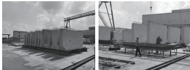
图 6 道路挡墙预制拼装工艺施工
