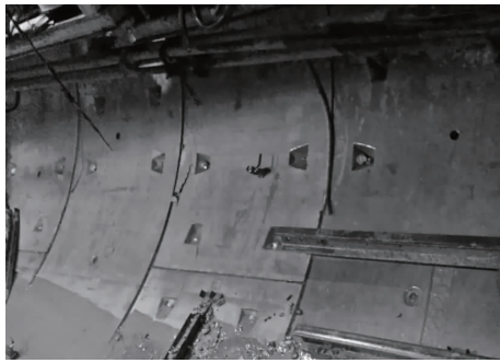
图9 隧道管片施加加强肋措施示意图
