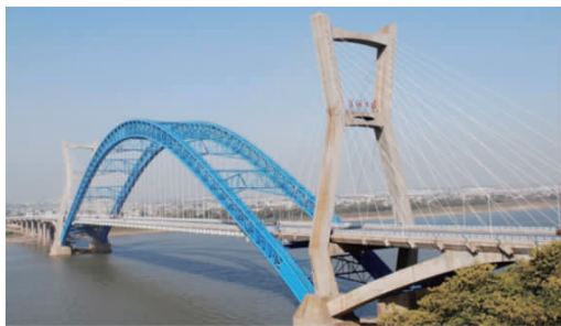
图 2 莲城大桥之实景
