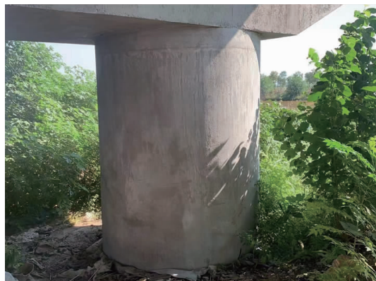
图 11 墩柱加固现状图
