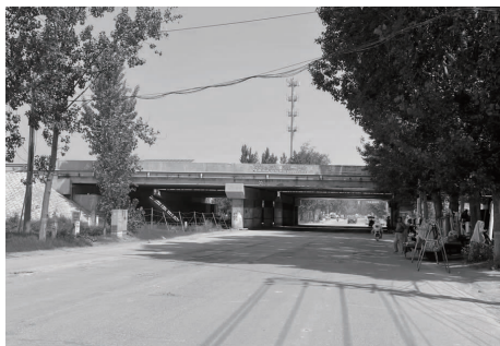
图5 下穿连霍高速现状照片
