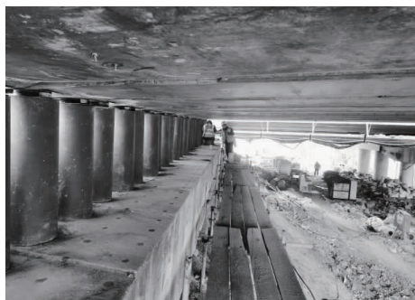
图 8 预制垫石安装完成施工之实景
