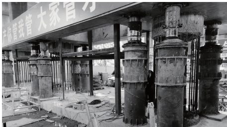
图 5 上下抱柱梁断柱顶升施工现场之实景
