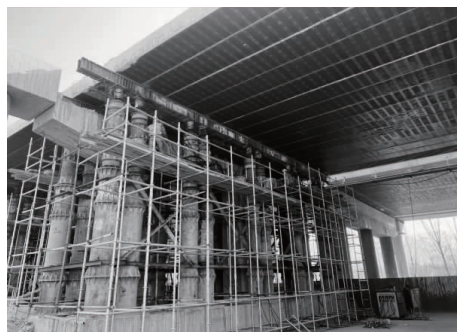
图4 新建下抱柱梁顶升施工之实景
