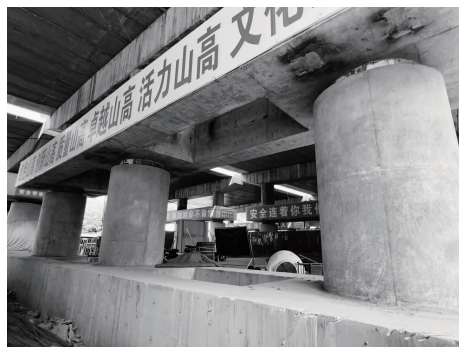
图 10 断柱连接加粗完成施工之实景
