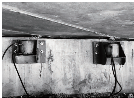
图 6 植入钢牛腿顶升法施工现场之实景
