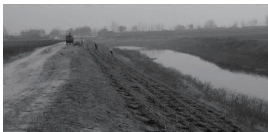
图4 孝妇河现状坝顶土路
