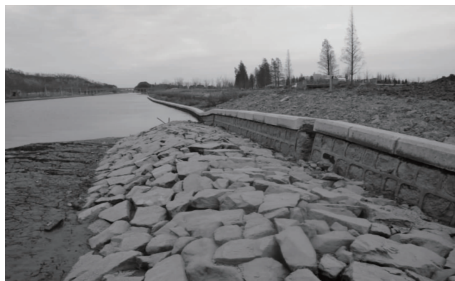
图3 临近堆土体的河道底部隆起
