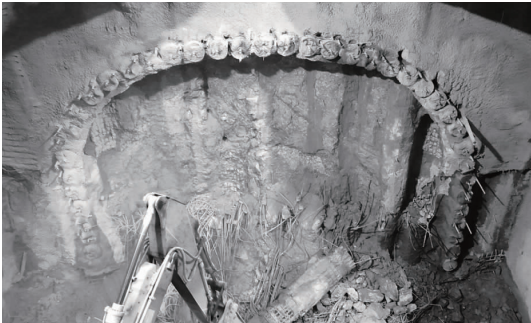
图 6 管幕施工图
