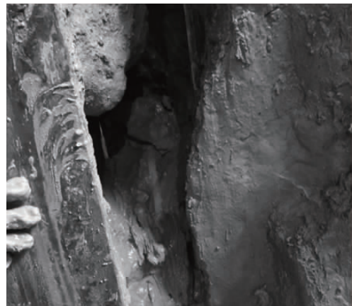
图 1 接缝夹泥
