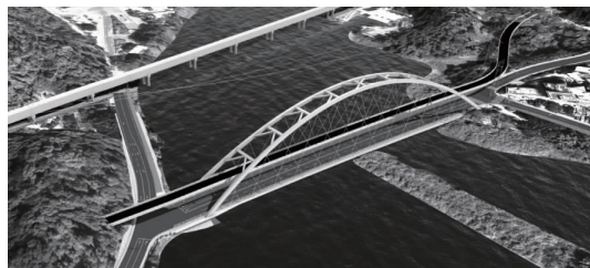
图7 推荐方案(拱脚正位、K型风撑)
