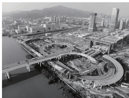
图2 现场施工照片
