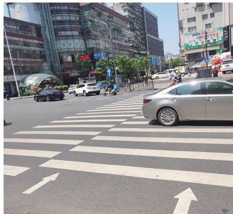
图 7 象山路部分路口双向错位人行横道布置实景
