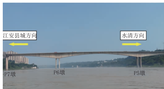
图1 某长江公路大桥现状
