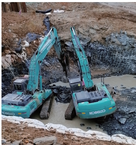
图5 扩大基础施工过程2
