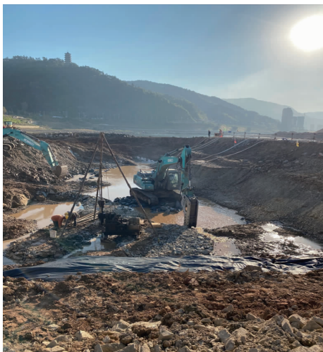
图4 扩大基础施工过程1
