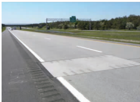
图1 装配式道面技术在美国27号公路中抢修的应用之实景
