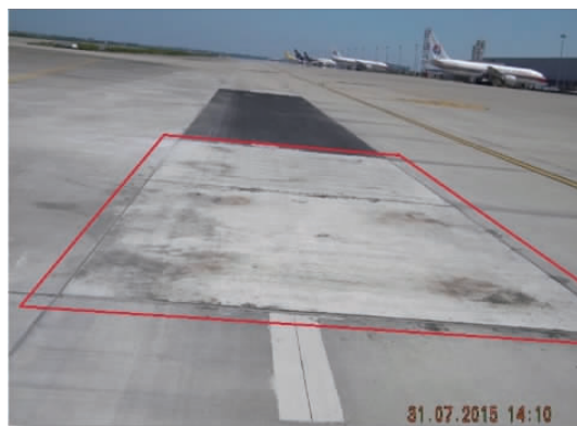
图4 修复后的道面状况实景
