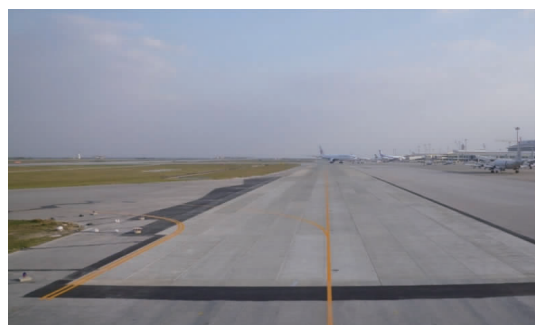
图2 装配式道面技术在福冈机场中的应用之实景
