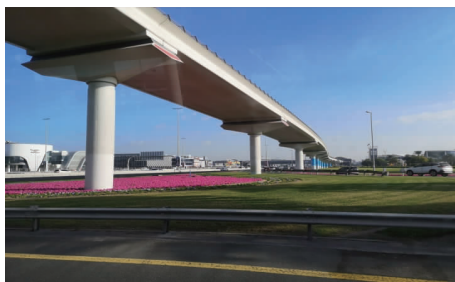
图 6 轻巧的跨线桥梁
