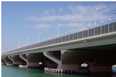
图 15 新颖的 Y 型桥墩
