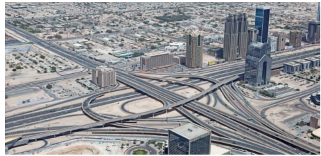
图10 迪拜立交桥梁图片1
