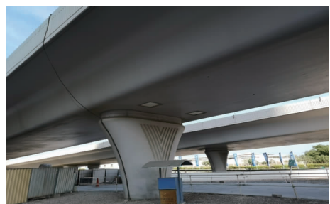
图14 工业化理念制造的新型桥墩图片2
