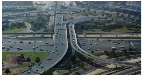
图11 迪拜立交桥梁图片2
