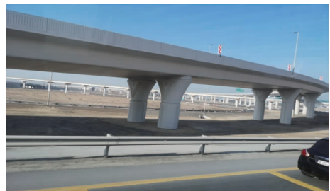
图13 工业化理念制造的新型桥墩图片1
