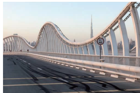
图 17 新颖的桥梁防护装置
