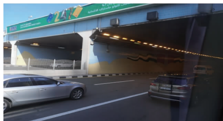
图 7 闭合箱型立交桥梁
