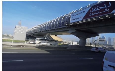
图 16 封闭型的组合栏杆和隔音屏蔽墙
