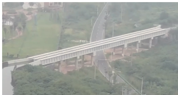
图 17 建成后 1 号过水桥
