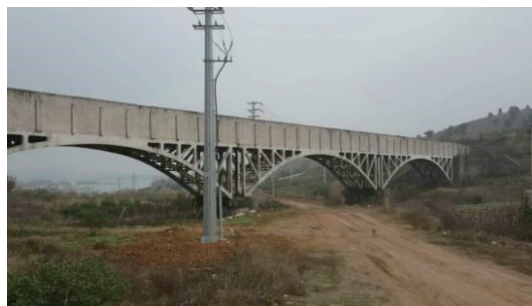
图1 原湫湖灌区1号过水桥现场照片
