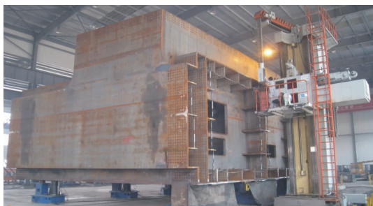
图5 钢塔端面加工及端面刚性加固
