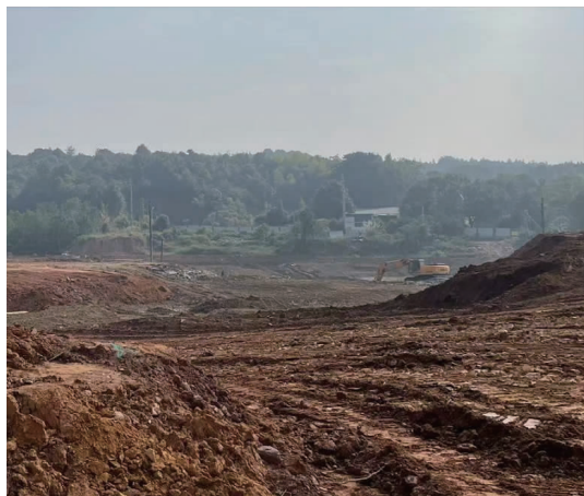
图 2 湖南省益阳市经济开发区团圆南路道路工程项目施工现场
