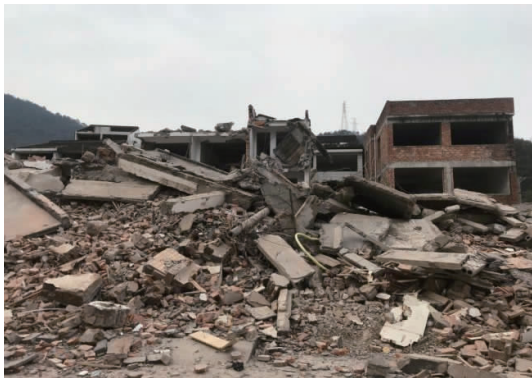
图 1 城中村改造拆迁现场
