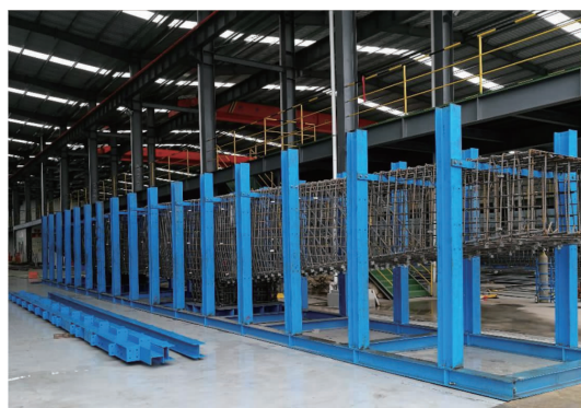
图3 盖梁钢筋制安
