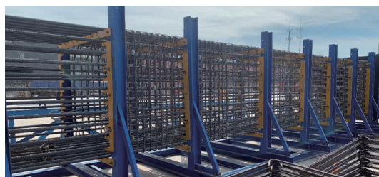
图2 立柱钢筋制安
