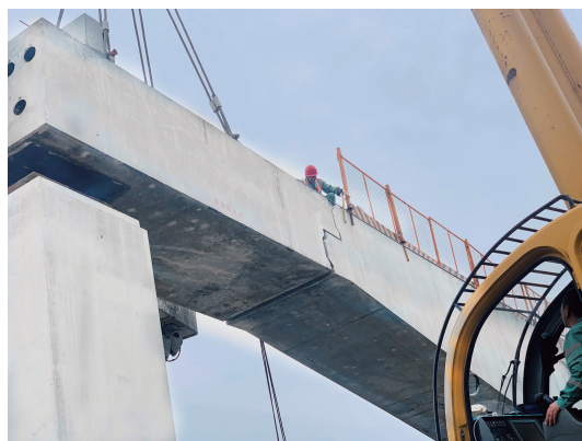
图8 盖梁边节段安装
