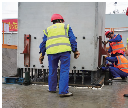
图9 立柱安装
