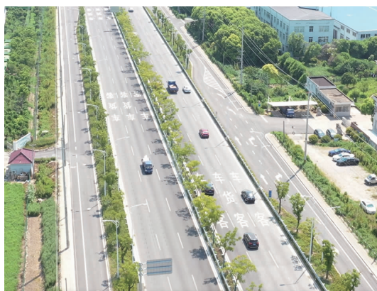
图4 联络道采用右出右进控制的接入口
