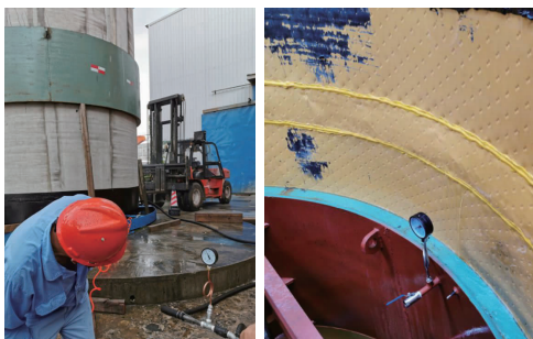
(a)HDPE 内衬接口 抗外水压试验测试 (b)HDPE 内衬接口 抗外水压试验测点
