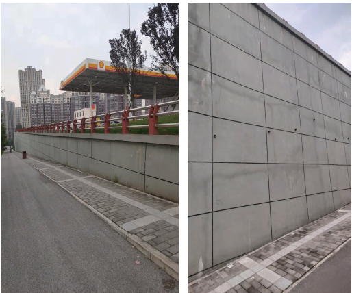
图3 排桩挡墙建成效果
