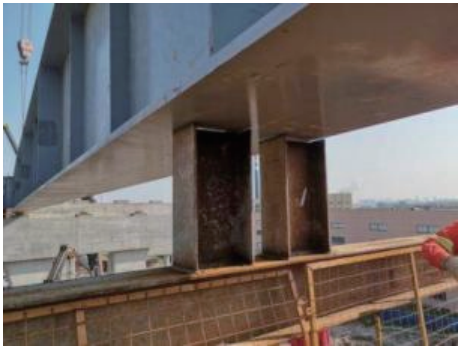
图 12 单梁一端用牙板固结于临时支架上
